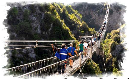
Ponte Tra i Due Parchi
